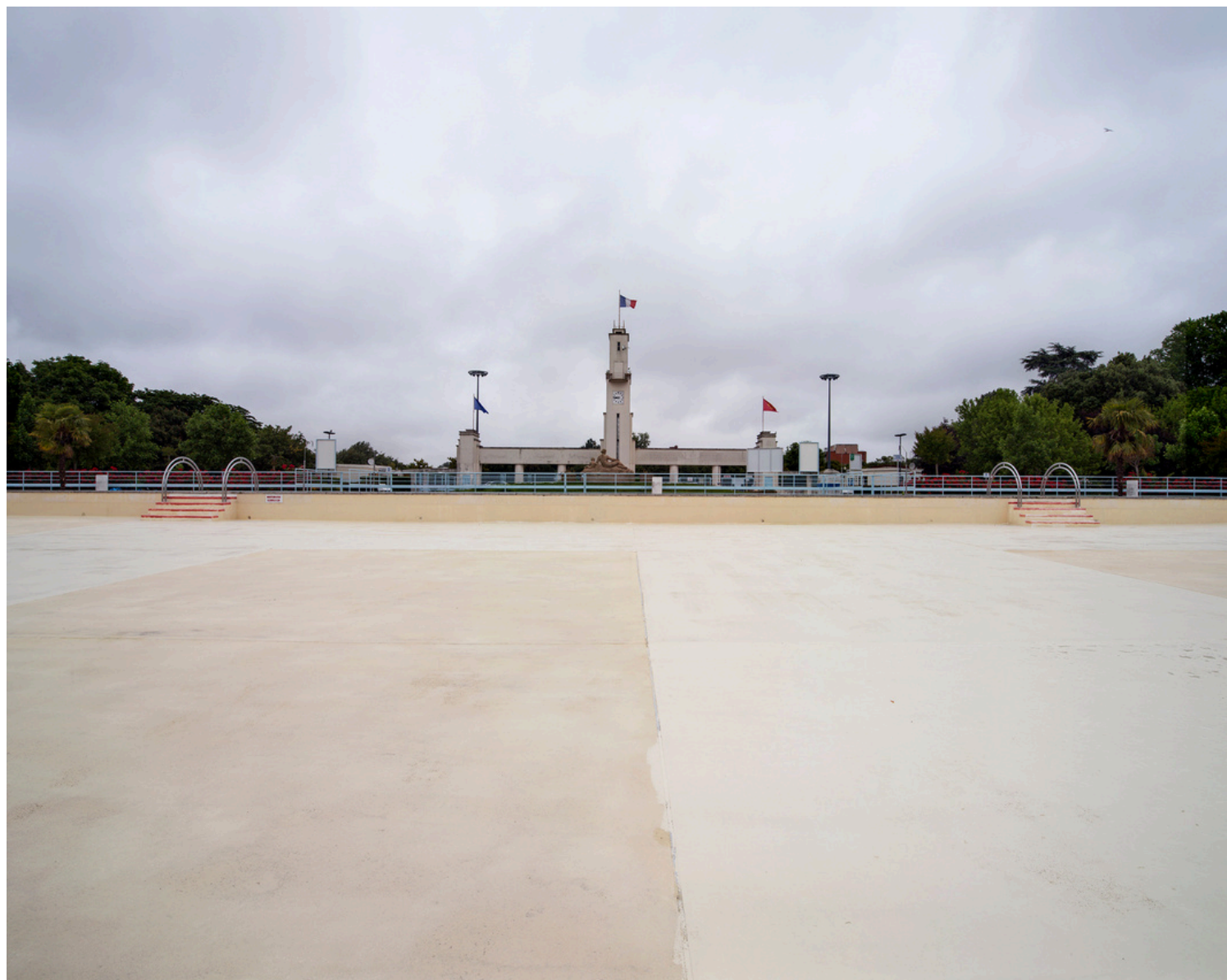
ENTRE DEUX EAUX Piscine Nakache - Toulouse © Arnaud Chochon Photographies
